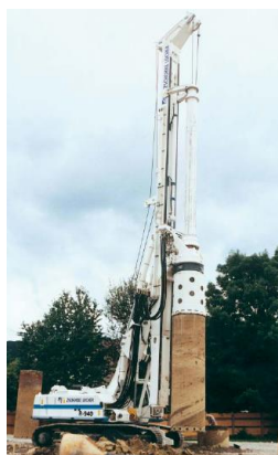
Verrohren (abwechselnd) bis Endtiefe - Inserimento camicia rivestimento foro
