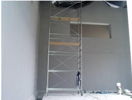
um auf die Arbeitsebene zu gelangen, ist eine innenliegende Leiter vorzusehen die Radsperre aktivieren Va prevista la scala interna per accedere al piano di lavoro Bloccare le ruote
