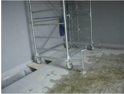
Achtung auf Bodenöffnungen - Attenzione alle aperture nel pavimento
