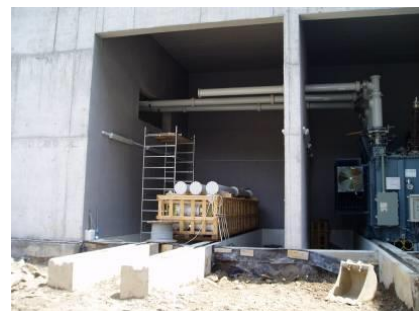
Um die Arbeitsebene muss ein genormtes Geländer laufen Va messo idoneo parapetto attorno al piano di lavoro
