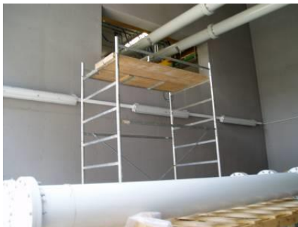
Es ist untersagt, seitlich herabzusteigen Um die Arbeitsebene auf angemessene Weise erreichen zu können Vietato scendere lateralmente muss deren Höhe entsprechend gewählt werden
